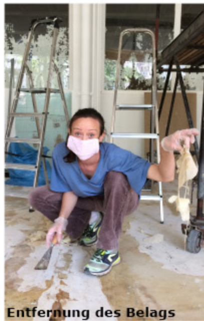
Materialisierung der Textilwerkstatt im Rohbau
